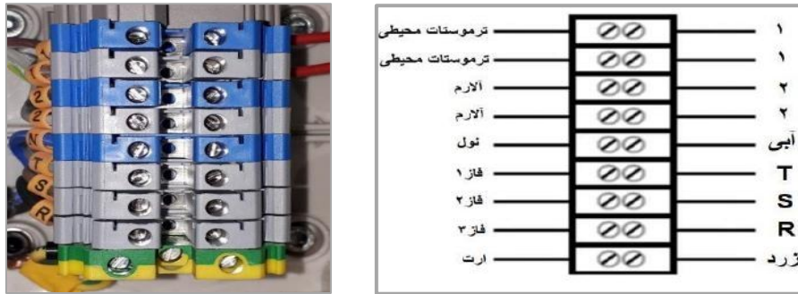
شکل ۱۴) اتصالات ترمینال‌های ورودی
