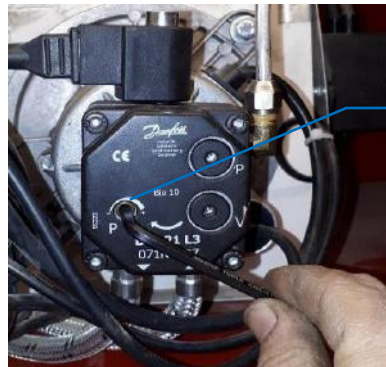
شکل (۱۵) محل تنظیم فشار گازوئیل
